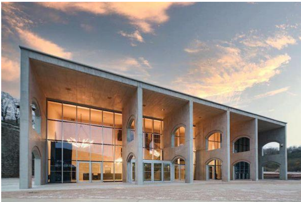
L'Arche, nouveau centre culturel à Villerupt (quartier Micheville), où s'est déroulée la conférence ministérielle © Bartosch Salmanski / K Architectures
