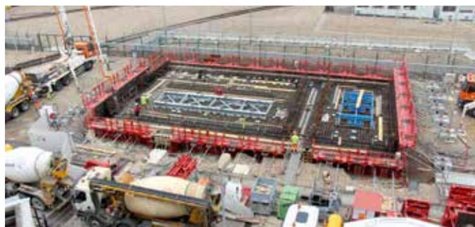
actuel. L'exigence de robustesse impose la réalisation d'un bâtiment sur plots parasismiques, le calage du plancher bas au-dessus du niveau d'inondation de référence, mais également la construction d'une structure et d'équipements extérieurs dimensionnés pour résister à la tornade de référence.
